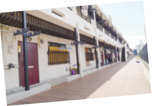
老朽化のため改修工事された堀川団地
